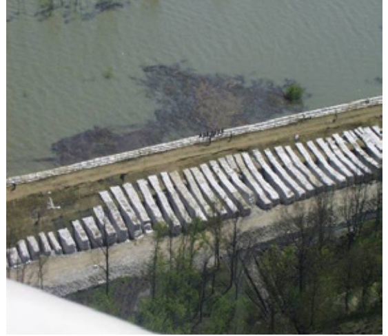
Csurgás elzárása fóliaterítéssel és homokzsákokkal
