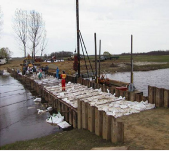
Védekezés rézsúcsúszás ellen bordás megtámasztással
