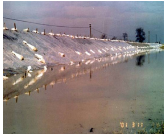
Csurgás elzárása fóliaterítéssel és homokzsákokkal
