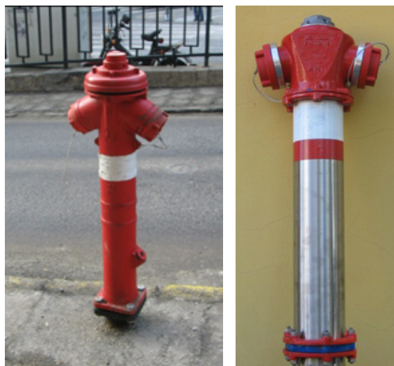
Hagyományos öntöttvas, és új korrózióálló-acél anyagú föld feletti tűzcsapok szabályos megjelöléssel
