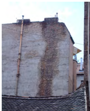
A kéménykorrózió hatásai
