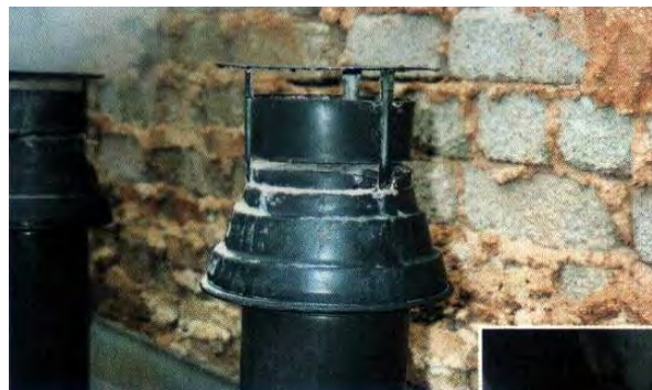
Falazott kéménycsoport mellé szerelt túlnyomásos égéstermék-vezeték
