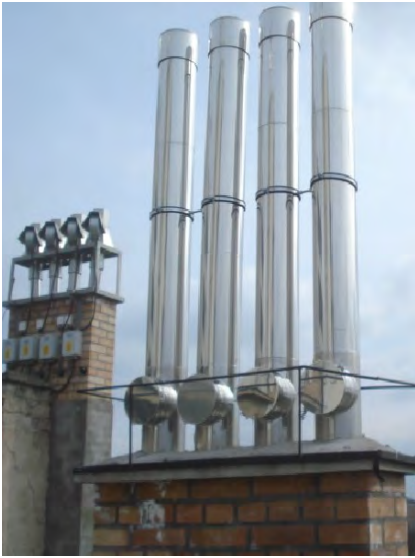
Kéménytoldók telepítése falazott kéményfejen
