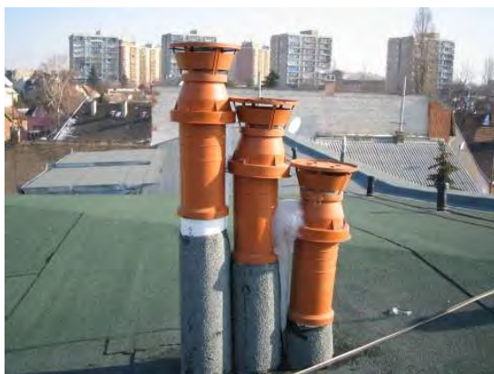
A nem megfelelő szerelési távolság következménye
