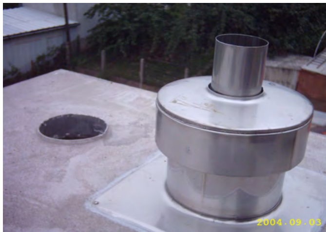
A szomszédos járatból kiáramló égéstermék bekeveredhet az égési levegőbe
