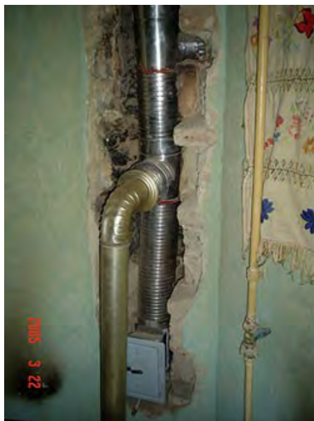
Merev és hajlítható utólagos fém bélésűvezetések
