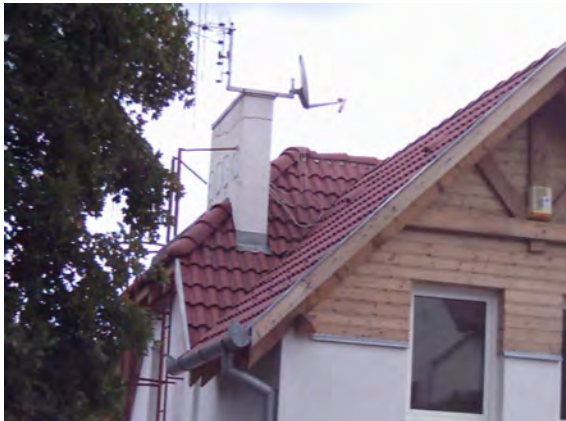
Falazott kéményfej tartószerkezetként való felhasználása
