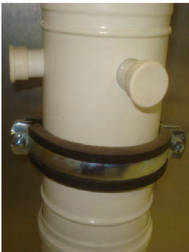
Égéstermék-levegő oldali mérőcsontok a „cső a csőben” rendszerű égéstermék-elvezetőben
