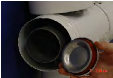
Túlnyomásos égéstermék-elvezető rendszer tisztítóidoma
